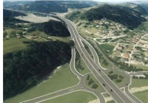
IZGRADNJA HITRE CESTE SKOZI VELENJE
